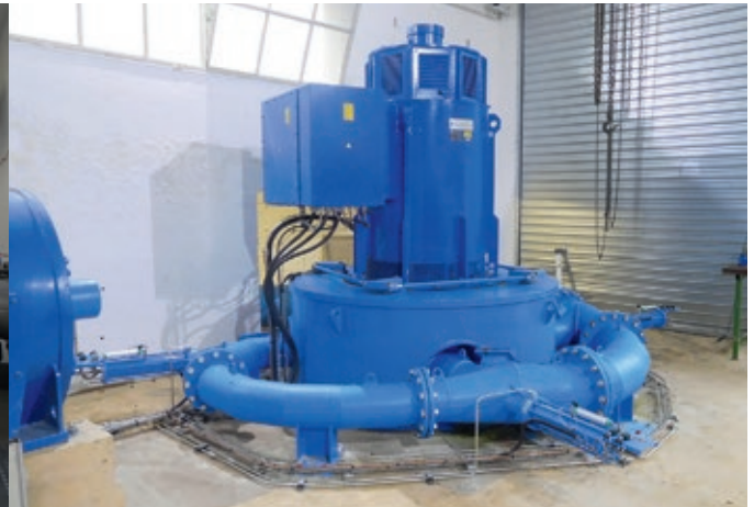
Turbine de Lafarge (France) à 4 injecteurs réalisée avec un répartiteur dans le plan de la roue (Q = 0.590 m 3 /s, Hn = 85 m, Dext = 838 mm, 600 t/min, Pm = 435 kW)
